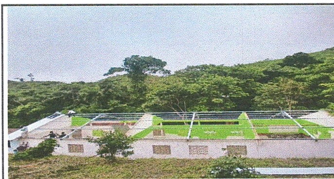
Foto 5: Instalando las constaneras
