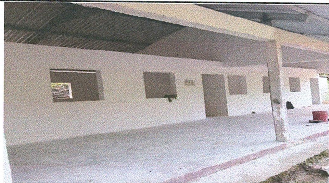
Foto1: La escuela ya casi finalizada su repello.
