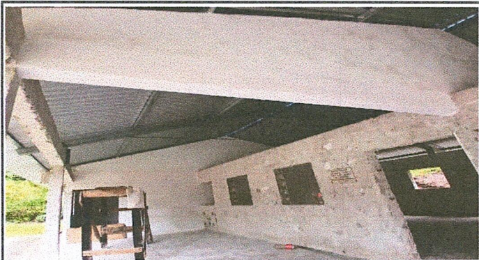
Foto 3: YA fue botando el antiguo repello y se colocará el nuevo repello
