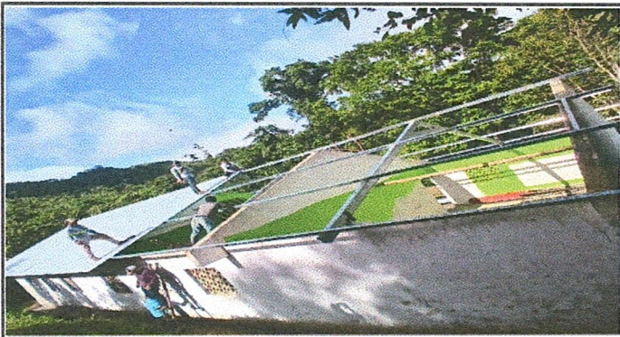
Foto 4: Colocando las laminas troqueladas.
